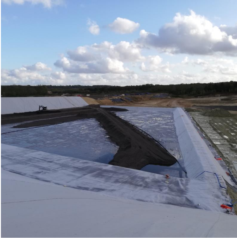
Mise en place des matériaux drainants
