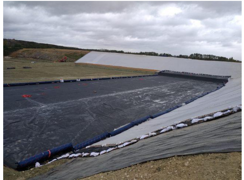
Mise en œuvre de la barrière de sécurité active
