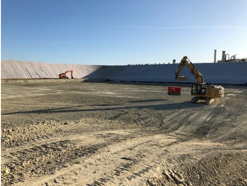
Mise en œuvre de la barrière de sécurité passive
